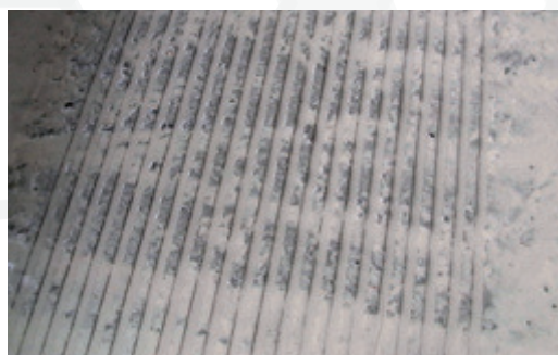
Rillenprofil in einer Betonfläche
